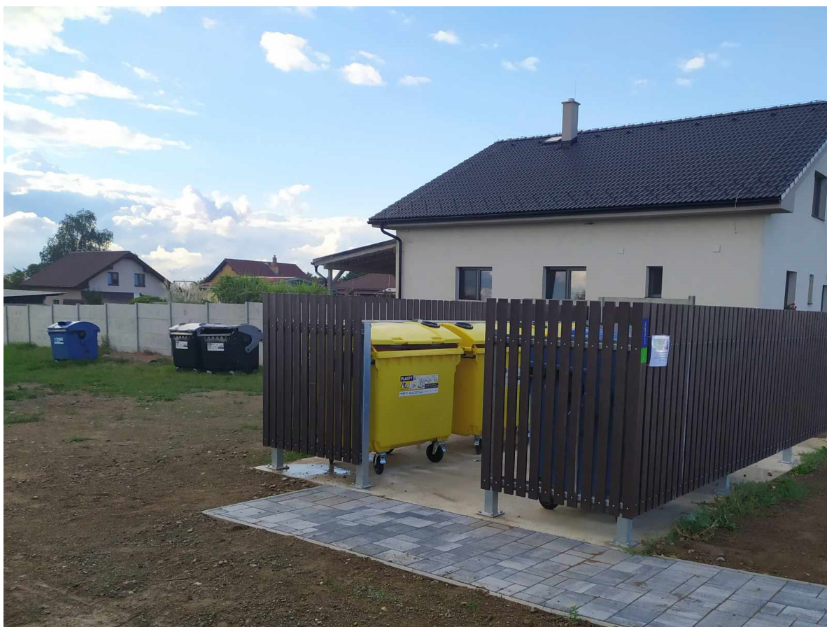
Vybudované nové kontejnerové stání, ZTV
